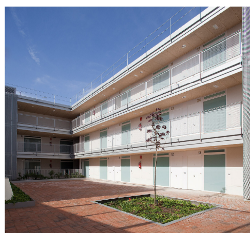
VISTA GENERAL DEL PATIO
