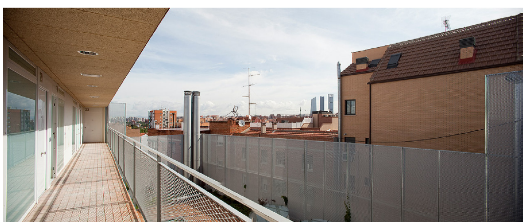
PASARELAS DE ACCESO A LAS VIVIENDAS
