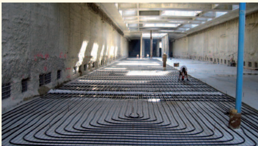
Ejecución de un tramo de losa termoactiva, sistema ENERCRET. ENERES - ENERCRET
