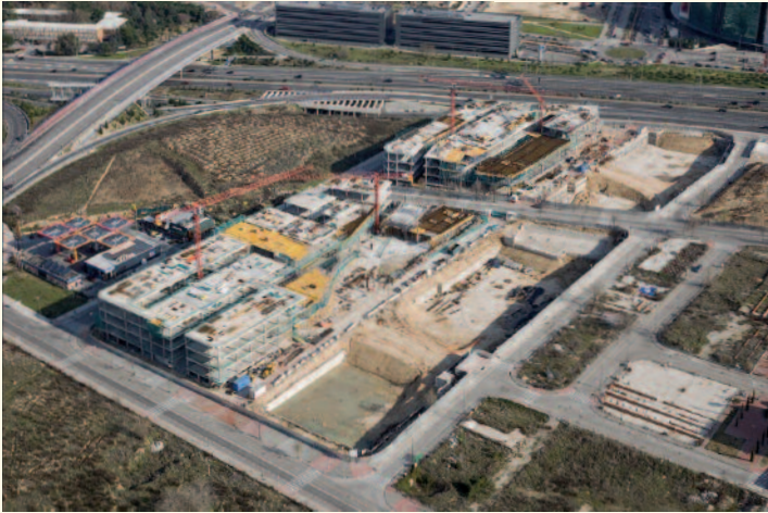
Vista general de las obras en ejecución. BBVA.
