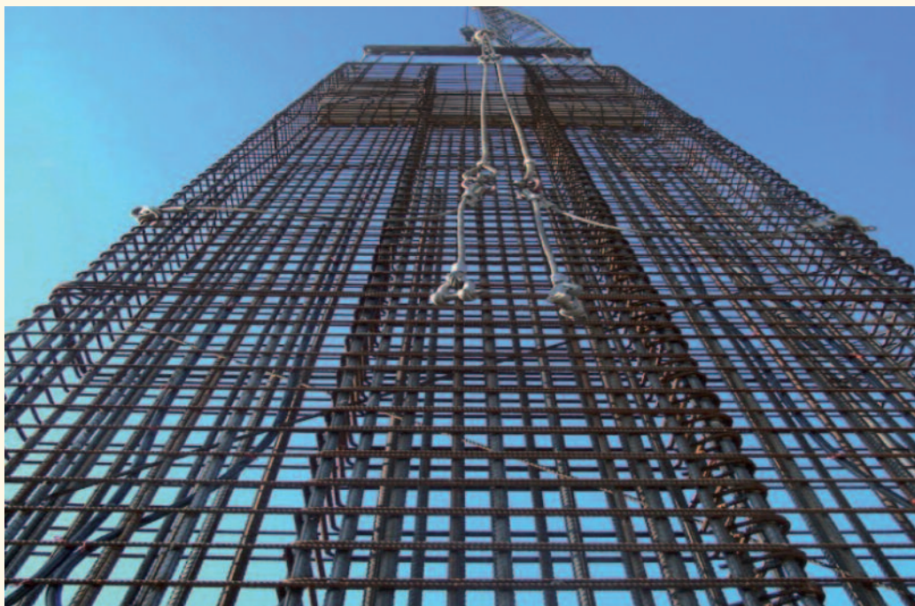
Ejecución de un tramo de muro pantalla termoactivo, sistema ENERCRET. ENERES - ENERCRET
