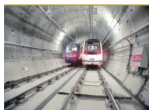
La estructura subterránea del Metro de Madrid. 287 km de túneles, 293 estaciones.
