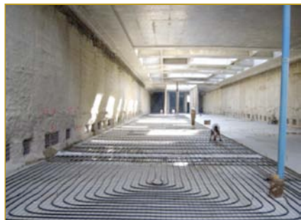
Pantallas y losas termoactivas en cuatro estaciones de la línea U2 del metro de Viena, aplicadas a la calefacción y la refrigeración de las zonas públicas.
