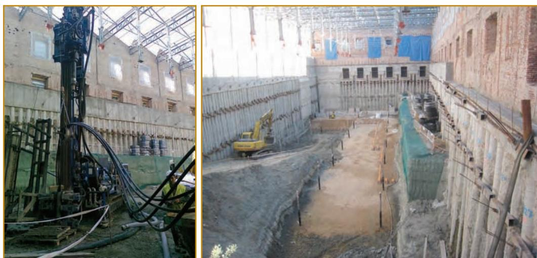
**Fig. 16. Ejecución de un intercambiador geotérmico agua/agua con 33 colectores verticales para calefacción y refrigeración y un intercambiador tierra /aire para el pretratamiento del aire de renovación, ambos integrados, en la rehabilitación del cuartel de Daoíz y Velarde para Teatro Infantil del Ayuntamiento de Madrid. Proyecto energético y ejecución ENERES**
