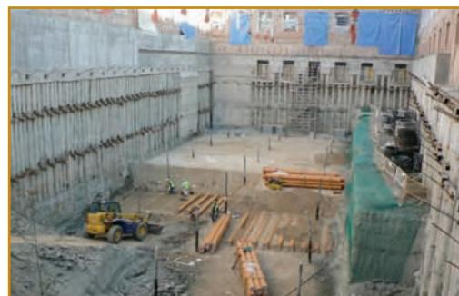
**Fig 20. Ejecución de los intercambiadores geotérmicos verticales del sistema de climatización y los intercambiadores geotérmicos horizontales del sistema de pretratamiento del aire de renovación.** Fuente: Eneres.
