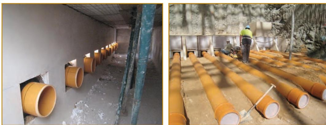
**Fig. 10. Colector de un intercambiador geotérmico tierra /aire con una capacidad de 24.000m<sup>3</sup>/hora, en la rehabilitación del cuartel de Daoíz y Velarde para Teatro Infantil del Ayuntamiento de Madrid. Proyecto energético y ejecución ENERES.**
