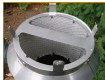
**Fig. 7. Detalles de la toma de aire de un intercambiador geotérmico tierra/aire.**
